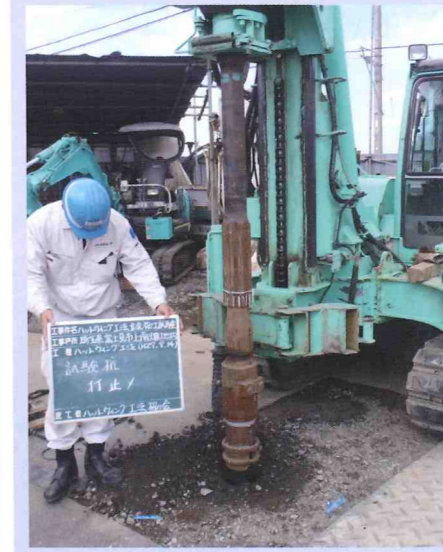
打設完了 (打ち止め)
