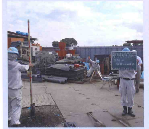
打設完了 (レベル確認)
