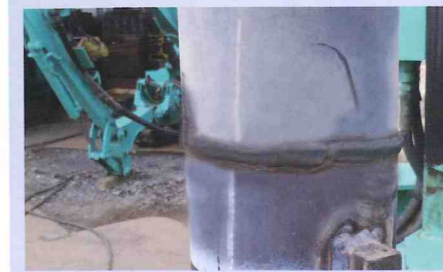
継手溶接完了
