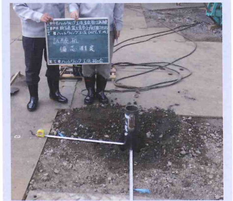
打設完了 (偏心確認)
